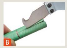
Äußere Heizbandisolierung bis zur 1. Markierung 33 mm entfernen. Schutzleiterlitze nicht beschädigen - Aufwölben der Isolierschicht vermeiden.
