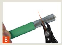
Schutzleiterlitze bis zur 20 mm Markierung zurückschneiden.
